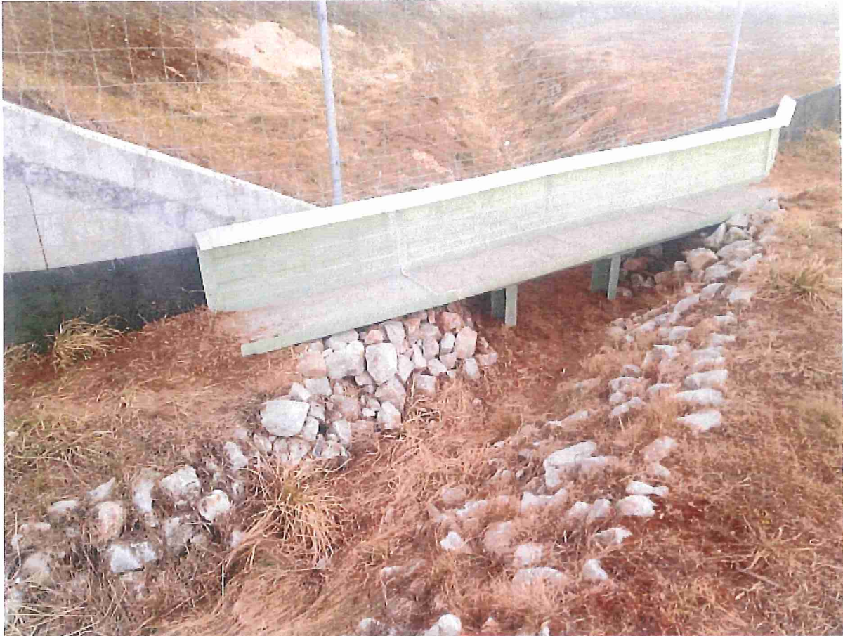
Przejście przez rów drogowy
